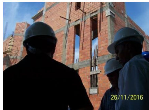
Fig.1 Visita técnica nos canteiros de obras
